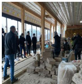
Im Ärdscheff: Als Baumaterialien werden Hanf und Lehm eingesetzt (Fotos: Schülerpool)
